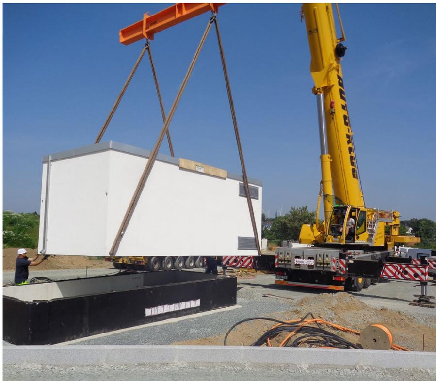
Des Weiteren wurden für die Stromversorgung des entstehenden Neubaubereiches zwei Trafostationen aufgestellt und es wurde das gesamte Leitungssystem für die Stromversorgung installiert.
